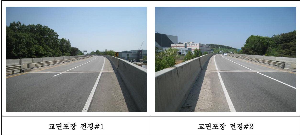
【사진 3.3.17】 교면포장 전경
