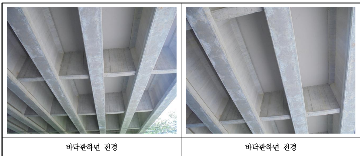
【사진 3.3.2】 바닥판하면 전경
