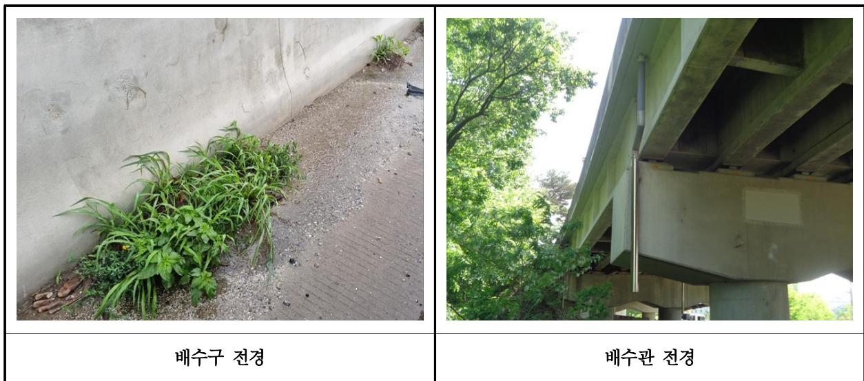
【사진 3.3.19】 배수시설 전경
