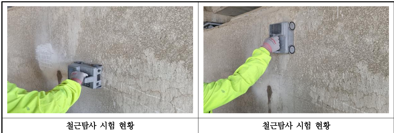
【사진 3.4.2】 철근탐사 시험
